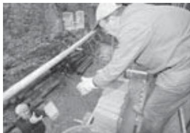
AUF DER BAUSTELLE ging es rund, da flogen auch schon mal die (erstaunlich leichten) Lehmziegel, mit denen die Gefache nach ur-altem Vorbild ausgemauert wurden. Foto: Fachwerk 1775
