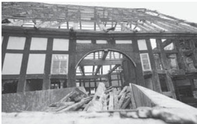
**DAS VIER-STÄNDER-GEBÄUDE** – eines der wenigen, die im Grönegau noch erhalten sind – wurde zu Beginn der Sanierungsarbeiten komplett entkernt.
