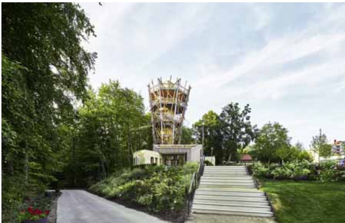
AUF DEM WEG zum Pavillon: Bei der Baukonstruktion wurde besonders auf umwelt- und klimaschonende Aspekte geachtet.
