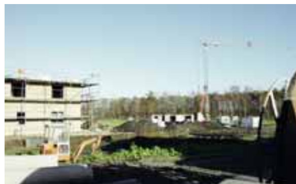
NEUE WOHNBEBAUUNG ENTSTEHT: Auch in Schwagstorf werden moderne Wohngebäude errichtet.
