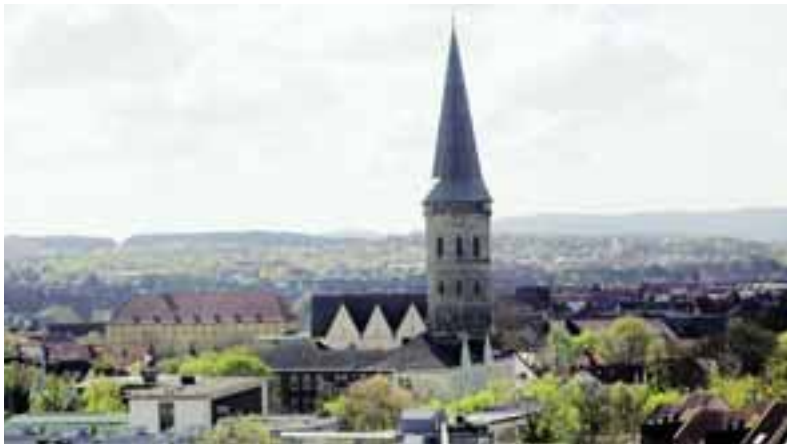
WEITHIN SICHTBAR: der markante Turm der St.-Katharinen-Kirche.
