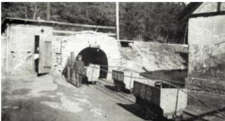
ARBEITER AM MUNDLOCH des Hasestollens, um 1894 von Alois Wurm fotografiert.
