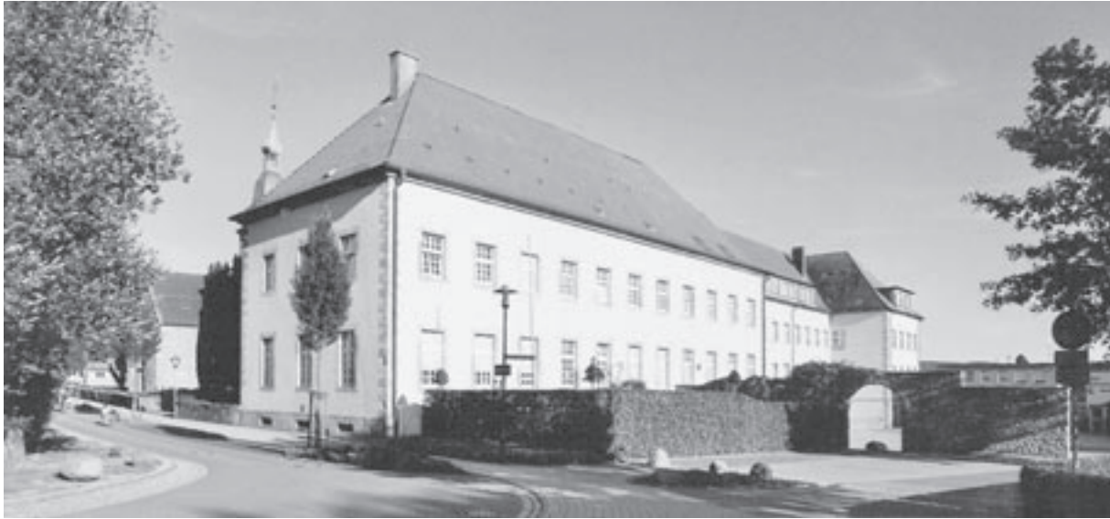
EIN WERK des Architekten Alexander Ludwig von Corvey: Die stattlichen Klostergebäude.
