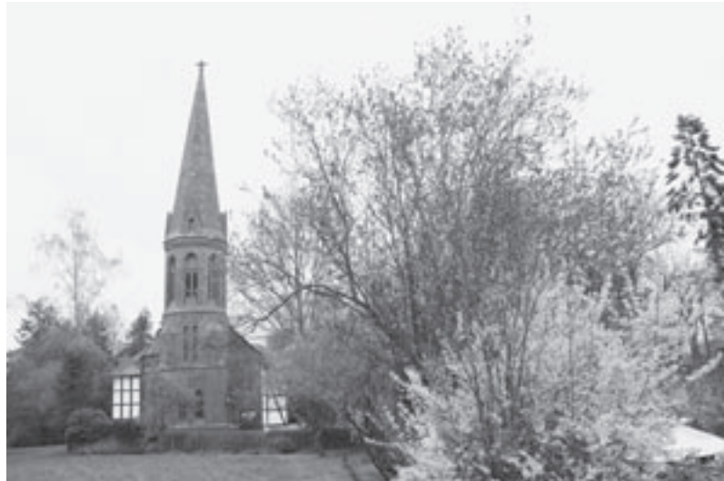
BILDETE DIE ERSTE STATION im Besichtigungsprogramm: Die St.-Johannis-Kirche in Arenshorst. Foto: Jürgen Krämer
