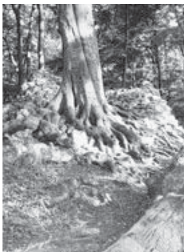
ZEITBOMBE: Die Wurzeln der Buche gefährden die baulichen Reste der Anlage.
