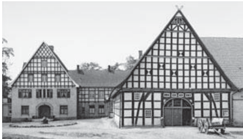
IMPOSANTE ARCHITEKTUR: Ein interessanter Aufsatz über die Hofstelle Meyer zu Malbergen findet sich ebenfalls im Heimat-Jahrbuch 2011.
