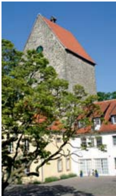
TRADITIONSREICH: Die Burg Wittlage steht am 25. April 2009 im Zeichen des Kreisheimattages.
