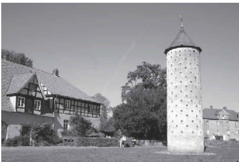
FASZINIERENDE ARCHITEKTUR: Alte Rentei und Taubenturm auf Schloss Hünnefeld im Wittlager Land. Foto: Jürgen Krämer
